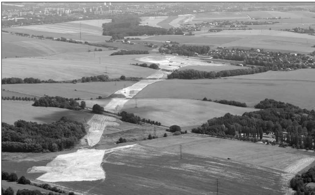
Hlavní těleso dálnice (Stavba 4707) se zkoumanou lokalitou u Klimkovic 1
